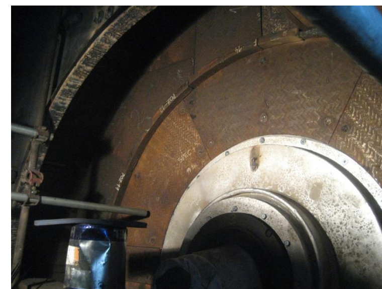
Oblaganje statora mlina pločama izrađenih od TNP
