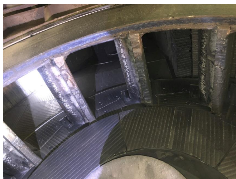
Oblaganje kućišta mlina TNP pločama
